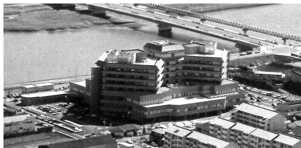
全病室への日照確保と北枕回避を両立させた赤穂市民病院
